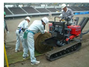
スタジアムでの施工の様子
