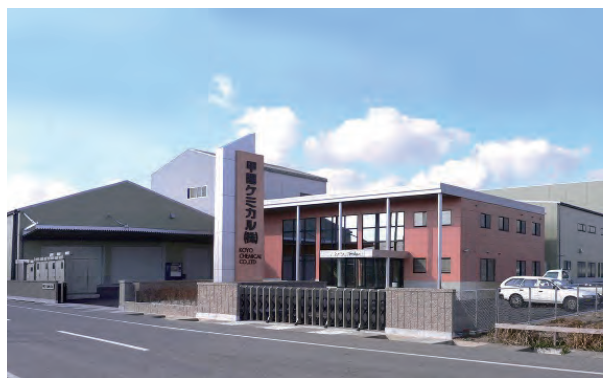
甲陽ケミカル(株)境港工場
