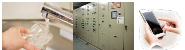
上下水道施設の遠隔監視システムで、いつでも安全な水が使えます
